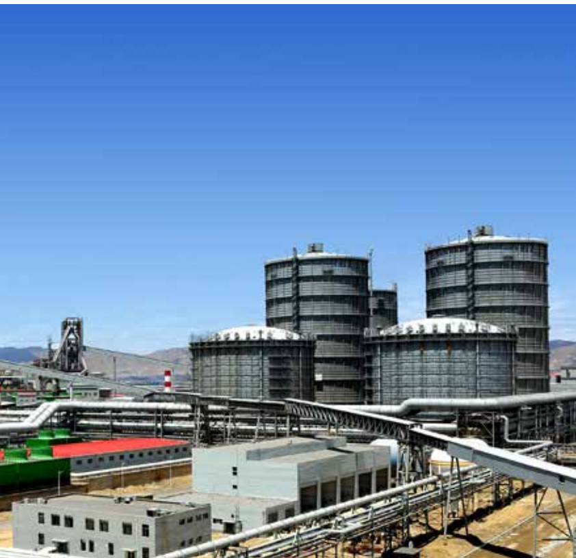
位于包头市北部的白云鄂博矿区是包钢集团的主要原料基地，那里蕴藏着占世界已探明总储量 18% 以上的稀土矿物。图为包钢稀土钢铁厂。
